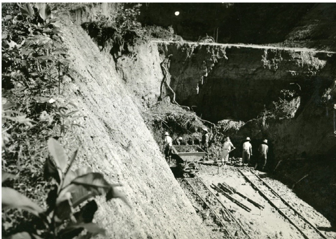
Foto 10. Trabajos en el corte en el kilómetro 45 1
